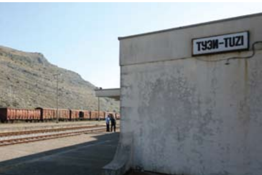
5. Željeznička stanica u Tuzima
