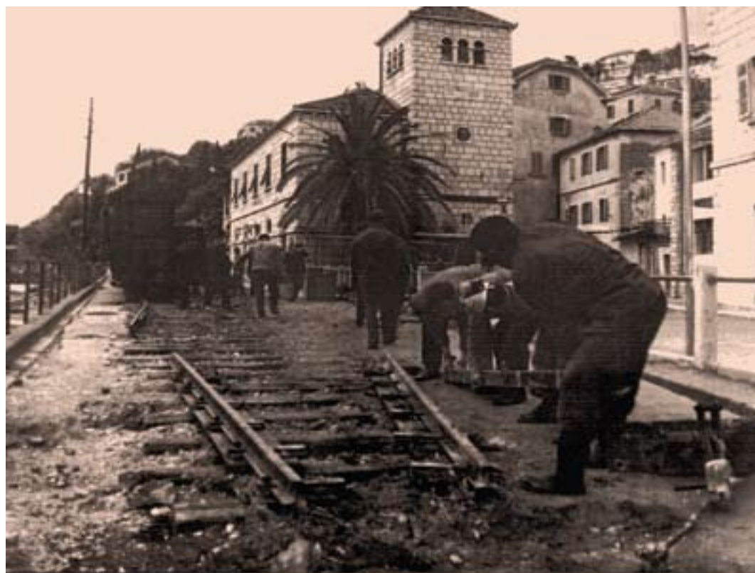
16. Demontiranje kolosijeka u stanici Herceg Novi, septembar 1968.
