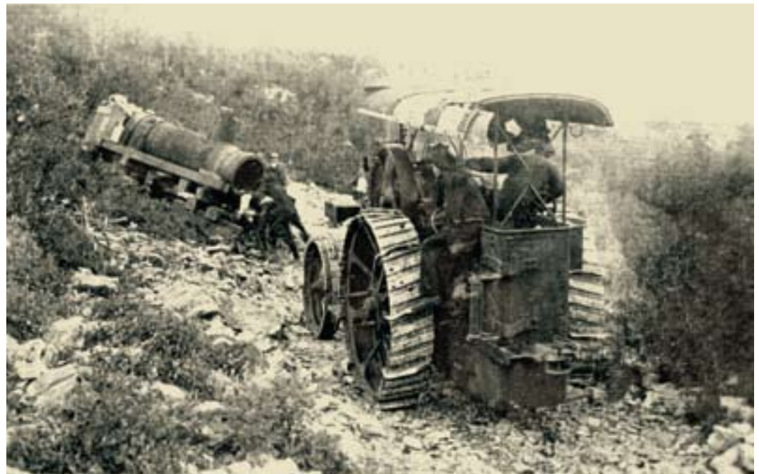
3. Transport kotla lokomotive šumske željeznice iz Bijele gore parnim traktorom, 1935.
