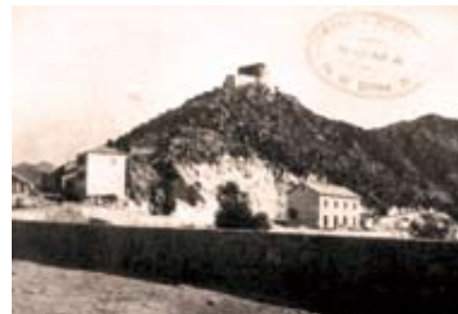
39, 40. Stanični objekti i radionice u Baru i Virpazaru
