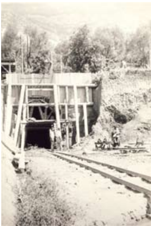
8. Početni radovi na izgradnji tunela „Sozina“, 1953.
