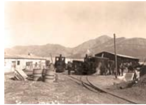
37, 38. Stanični objekti i radionice u Baru i Virpazaru
