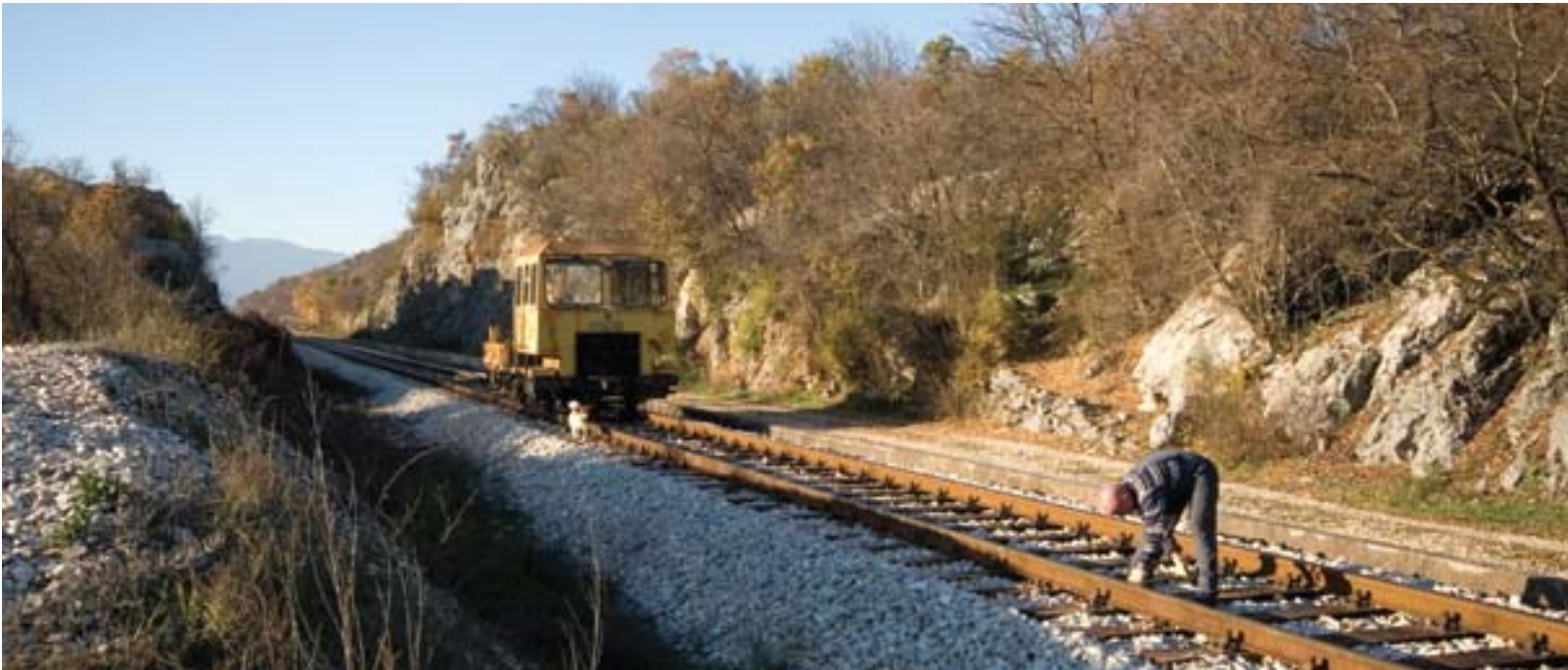
23. Radovi na rekonstrukciji pruge, Podgorica - Nikšić 2008.
